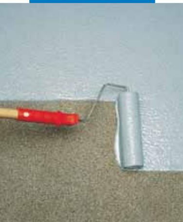
Rollapplikation von Mapecoat I 24
